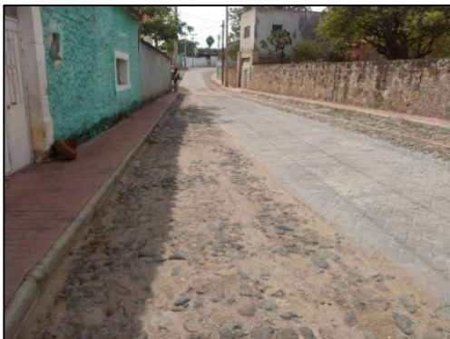
EMPEDRADO AHOGADO EN CEMENTO, EN CALLE ANTILLÓN.
