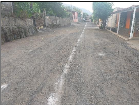
EMPEDRADO AHOGADO EN CEMENTO, EN CALLE ANTILLÓN.
