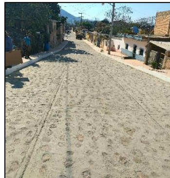
EMPEDRADO AHOGADO EN CEMENTO, EN CALLE ANTILLÓN.
